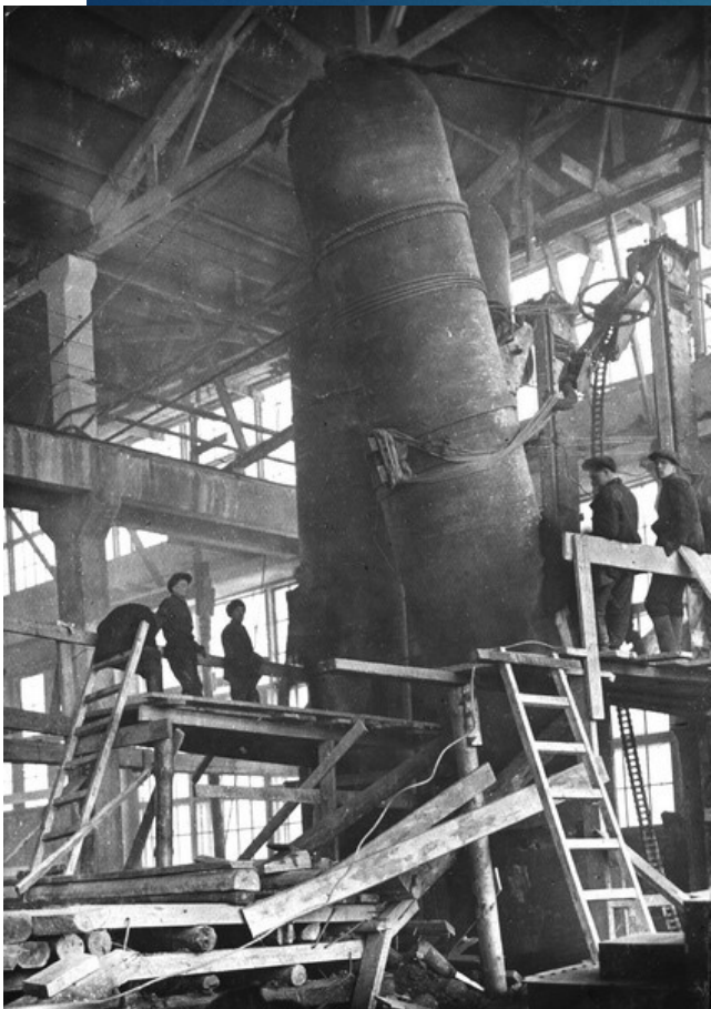
Монтаж оборудования трубопрессового цеха. 1932 г.
