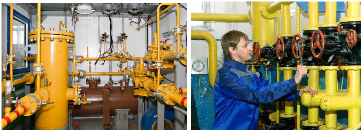
Рисунок 2.1. Проверка места соединений приборов на предмет утечки с помощью мыльного раствора
