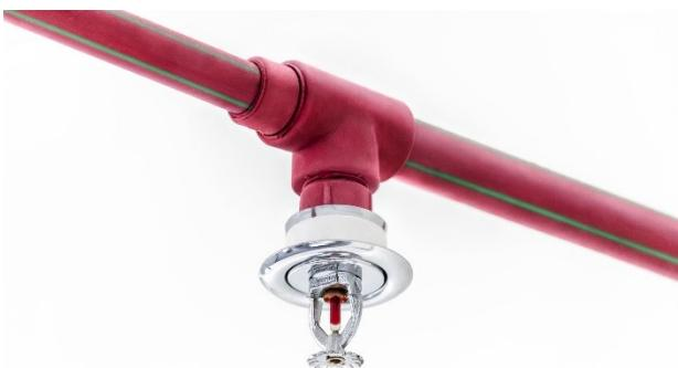
Принцип работы заключается в распылении огнетушащего состава на место пожара. Давление в трубах создается насосом-жокеем, вода подается с помощью спринклера – распылителя с тепловым замком.
