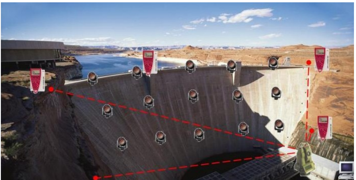
Рисунок 7 – Мониторинг на гидротехническом сооружении
