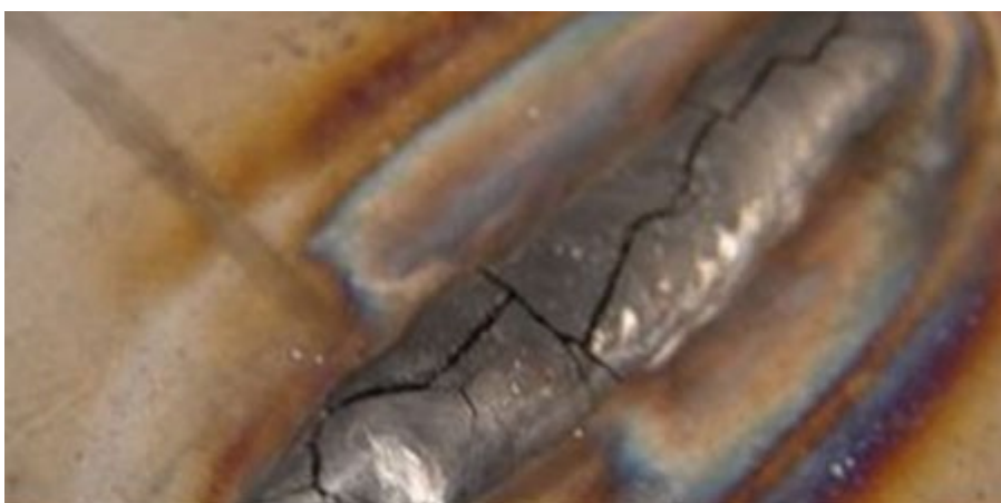
Дефекты сварного шва: трещины
