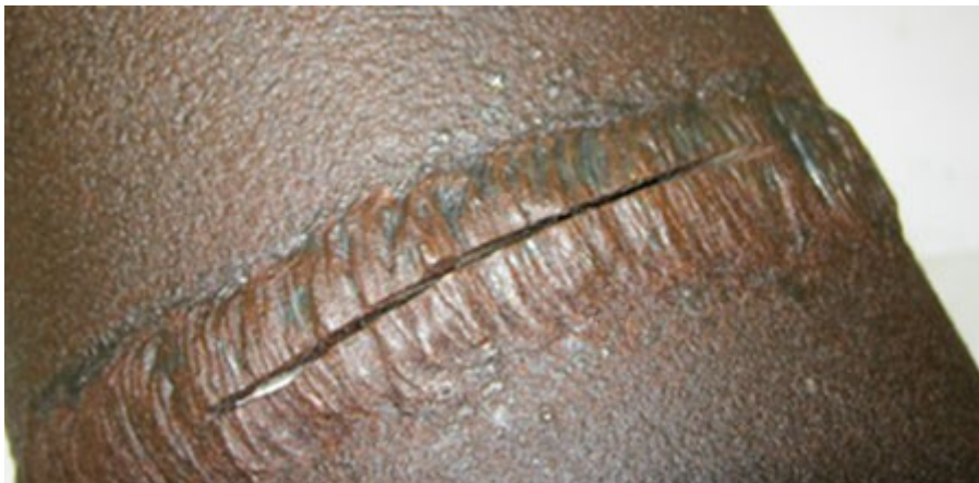
Дефект сварного шва: трещина
