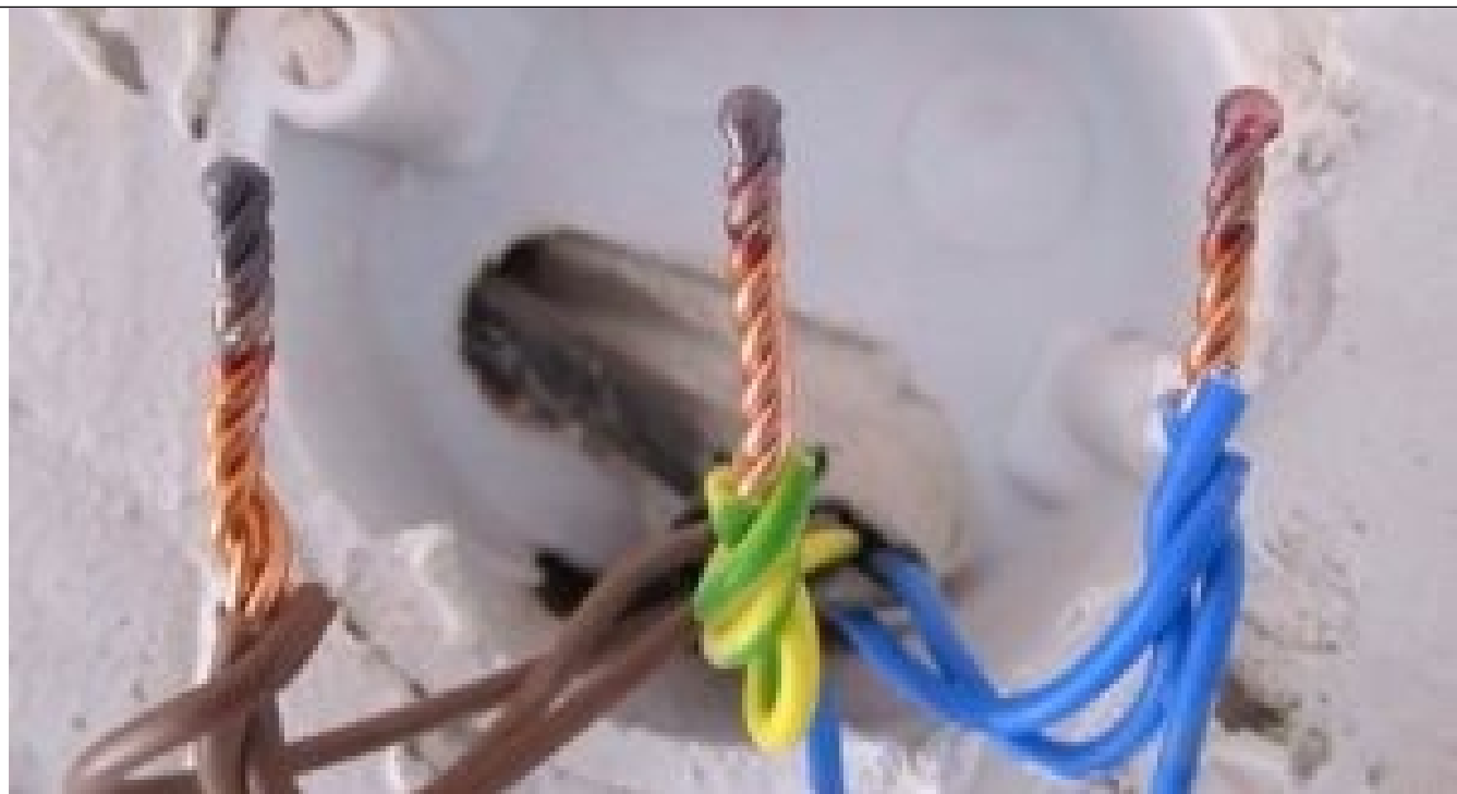
Рисунок 2. Пайка скруток проводников.
