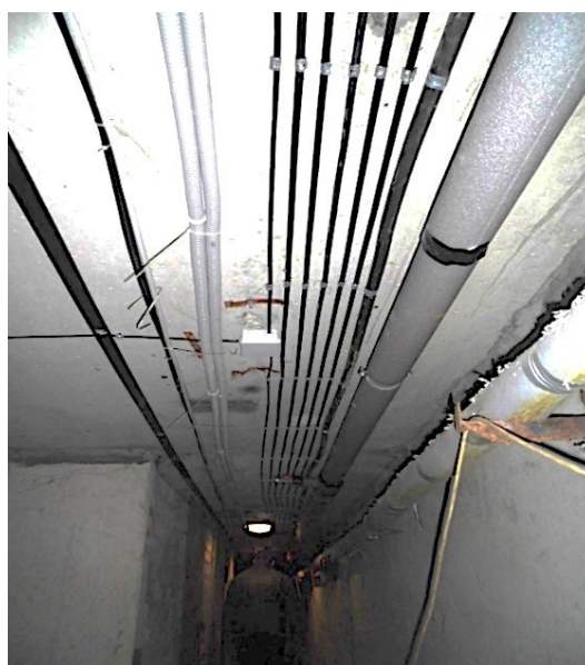
Фото 4 - Монтаж системы электроснабжения в подвальном помещении
