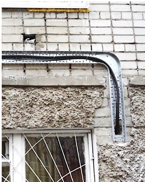
Фото 7 - Прокладка магистральных линий на фасаде дома
