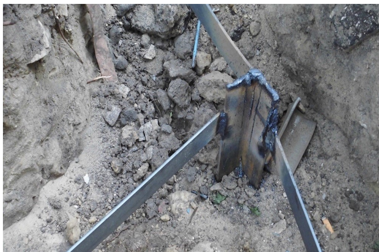
Фото 11 - Обустройство системы заземления
