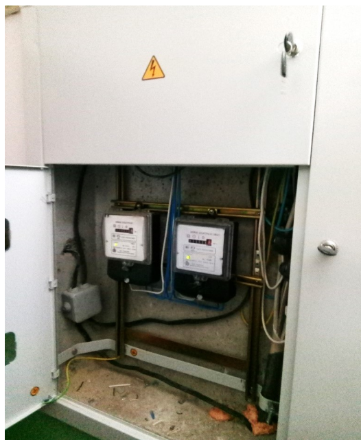
Фото 8 - Распределительный щит после проведенного капитального ремонта
