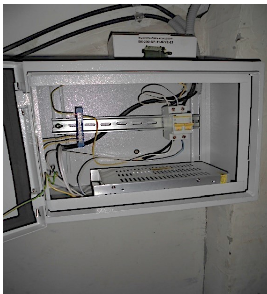
Фото 5 - Монтаж слаботочной системы освещения в подвале многоквартирного дома
